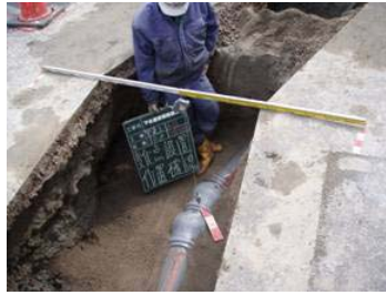
屈曲部での施工例（曲管設置）
