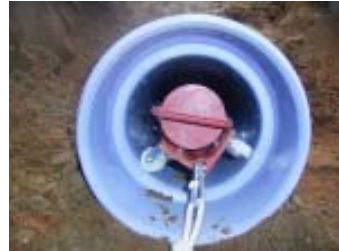
浮上防止対策（錘式）の施工例
