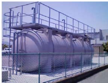
工場製作極小規模処理施設 地上設置例
