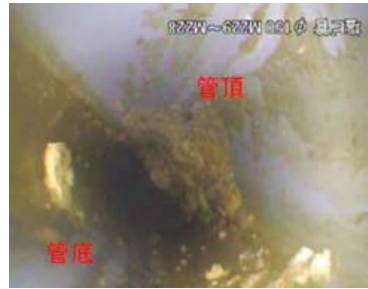
伏越し内の状況 (TVカメラ)
