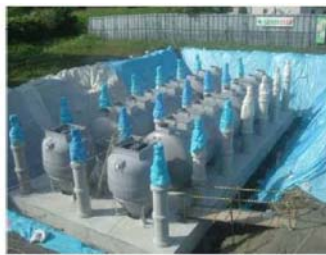
工場製作極小規模処理施設 地下設置例
