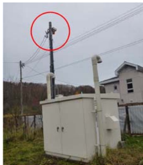
パトライト故障通報装置の設置例
