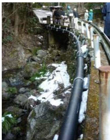
指示金具による基礎例
