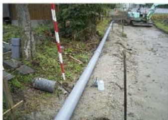
原地盤による基礎例
