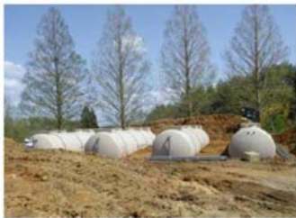
工場製作極小規模処理施設 半地下+盛土設置例
