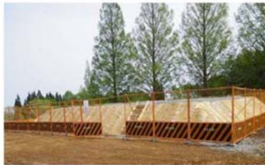
工場製作極小規模処理施設 半地下+盛土設置例
