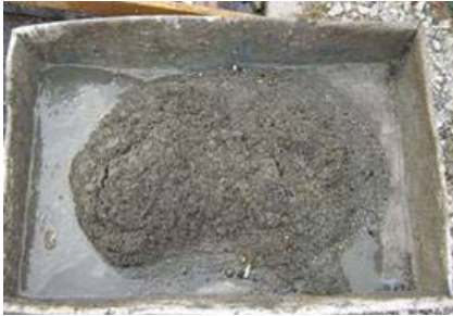
伏越し内堆積物の状況
