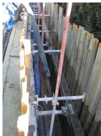
ポンプ圧送による打設状況
