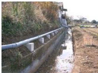
コンクリートによる基礎例
