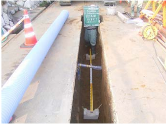
基礎の設置状況
