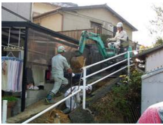
急勾配・狭小道路での施工例
