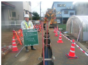
アジテータ車による打設状況
