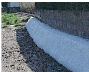
コンクリート巻立による防護例
