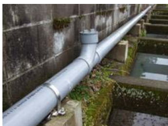
点検孔例①
