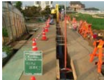
浮上防止対策（支柱式）の施工例
