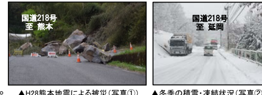
▲H28熊本地震による被災(写真①) ▲冬季の積雪・凍結状況(写真②)
