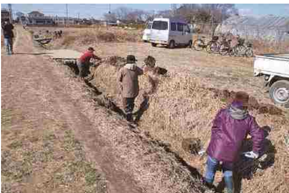
写真Ⅲ-52 土水路の維持
