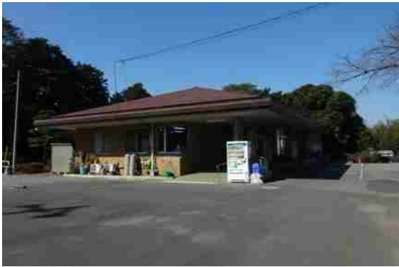
写真Ⅲ-22 松伏町老人福祉センター
