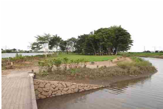
写真Ⅲ-34 堰・橋
