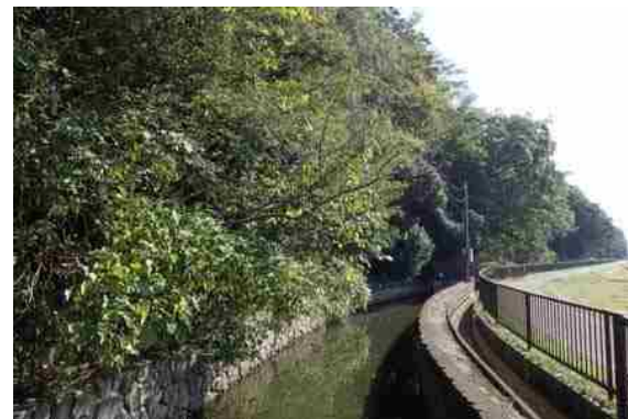
写真Ⅲ-27 金杉用水路
