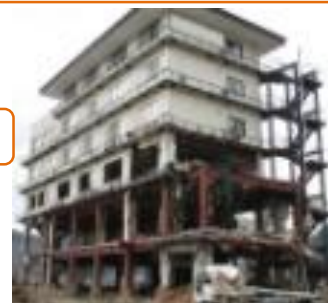
津波による外装材流出事例(宮古市)
