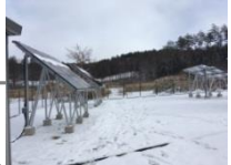
市内太陽光発電技術実証実験場 (融雪技術)
