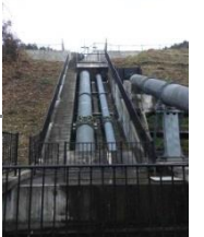
市内水力発電施設 (町川発電所: 最大出力140kw)
