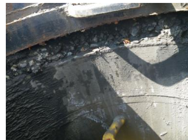
(調整コン破損)
