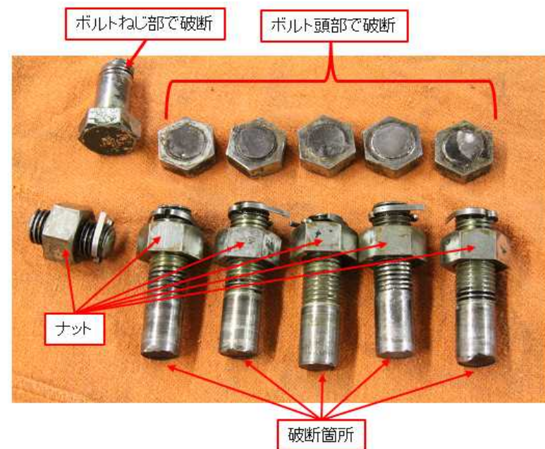
写真2 破断した六角ボルト
