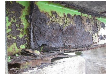
歩道(主桁 鋼材腐食)
