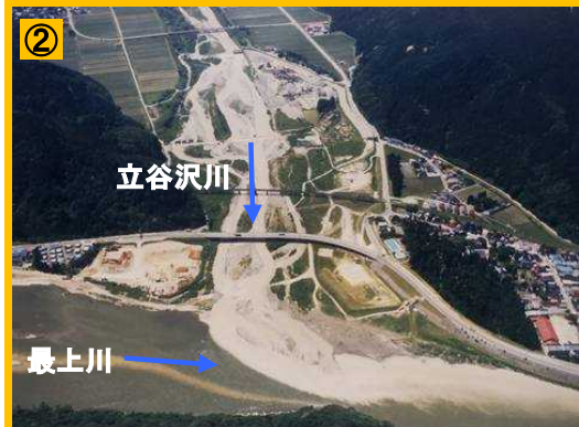
土砂流出状況
