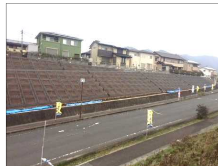
法枠設置状況(H30.8完成予定)
