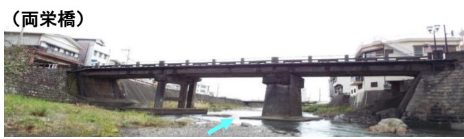
車道(主桁 剥離、鉄筋露出)
