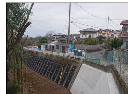
抑止工設置状況(H30.12完成予定)
