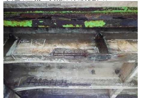
歩道(主桁 鋼材腐食)
