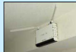
無料公衆無線LAN環境の整備
