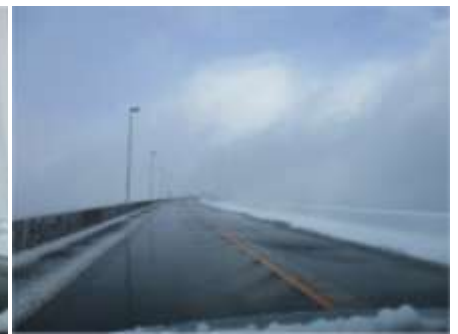
散水消雪区間
