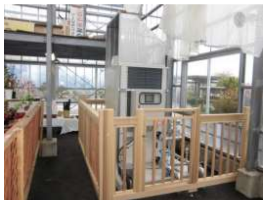
導入したヒートポンプ
