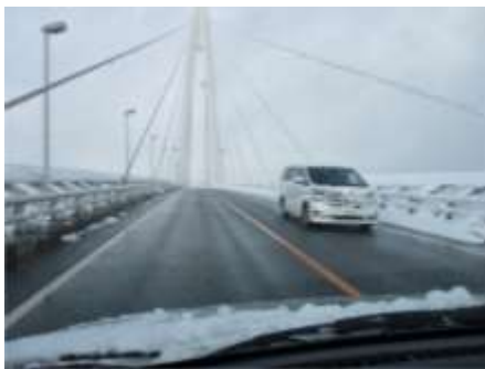
無散水融雪区間
