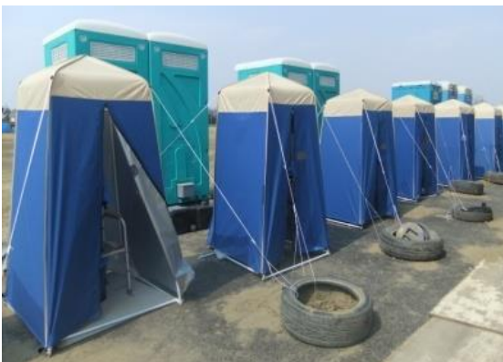
写真2-マンホールトイレの設置例 (国土交通省「マンホールトイレ整備・運用のためのガイドライン」より引用)
