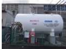
LNG燃料タンクシステム (省CO 2 率 23%、H28.3製品化)
