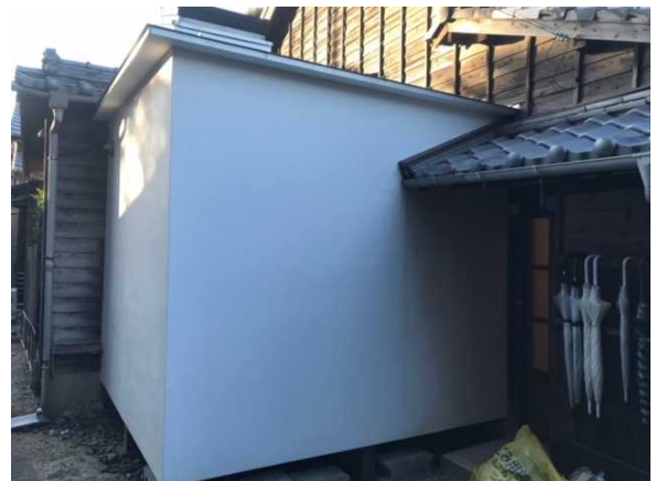
増築したトイレ部分
