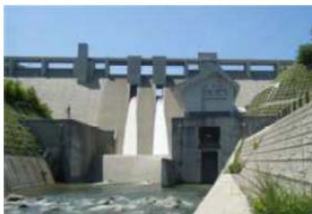
図 6 ダム CIM モデルの構造物例（横川ダム放流ゲート）
