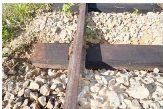
写真17 犬釘は正しく打ち込む
