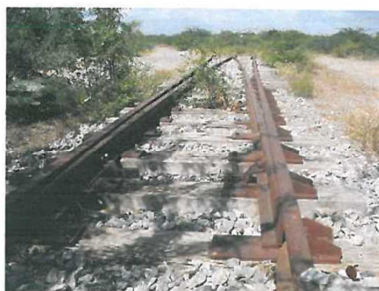
写真 2-14 P31 号分岐器ポイント部
