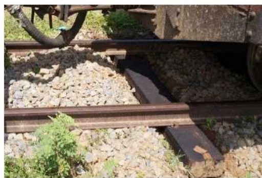
写真20 まくら木を交換したら埋め戻す
