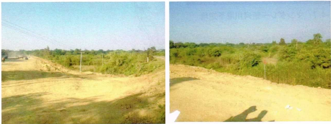
写真 1-2 、写真 1-3 新貨物駅予定地 ( 写真 1-4 の右側部分)
