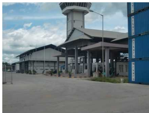
コンテナゲート外側
