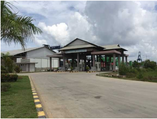
バリクパパン・コンテナ港ゲート
