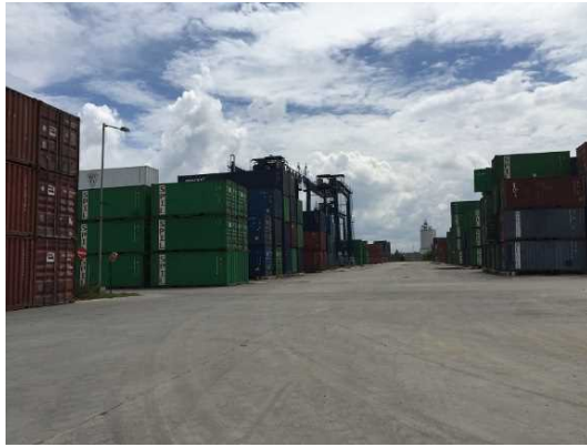
バリクパパン・コンテナ港内部
