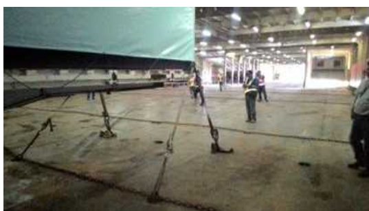
固縛作業の完了
