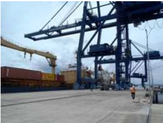
本船デリッククレーンと ガントリークレーンによる荷役
