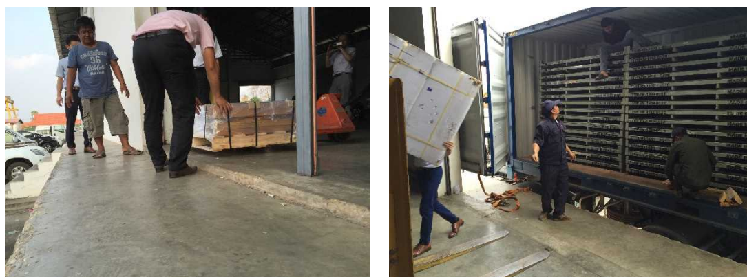
図 42 床の段差 搬出入口とトラックの段差
