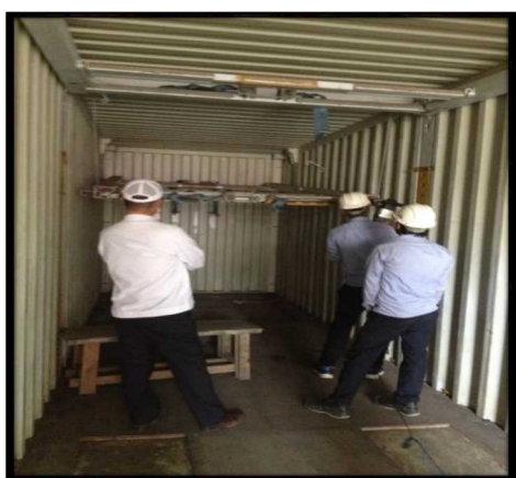
（奥側のラッキングシステムをおろす）
