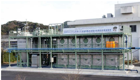
写真 実証施設外観
