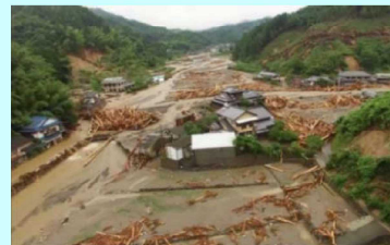
流木による被害(赤谷川、小河内川合流付近) 福岡県朝倉市
