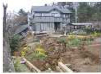
造成宅地の滑動崩落
