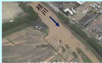
堤防決壊(桂川右岸) 福岡県朝倉市
