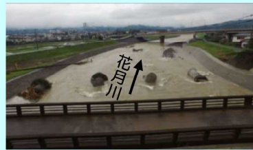
JR久大本線の鉄道橋流出 大分県日田市
