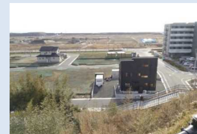
地区の状況(H29.12撮影)
