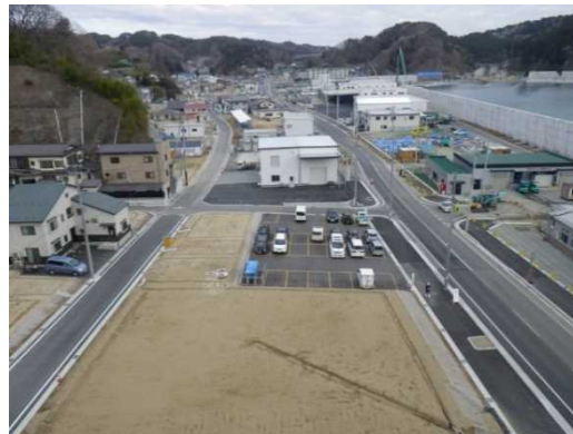
地区の状況 (H29.12撮影)
