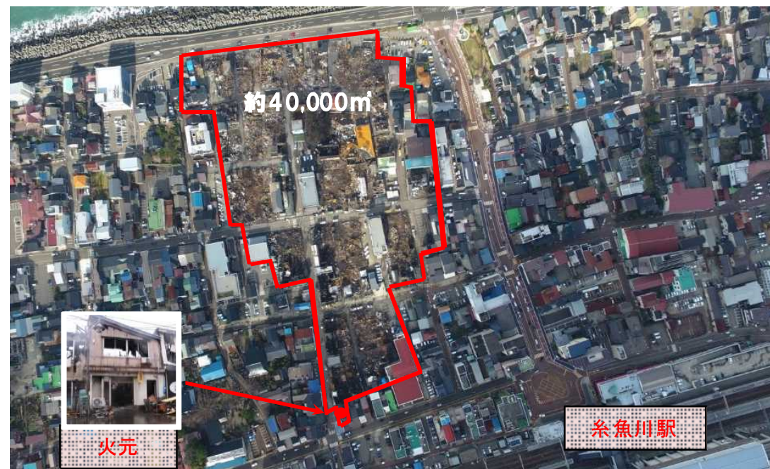
糸魚川大規模火災による被災状況
