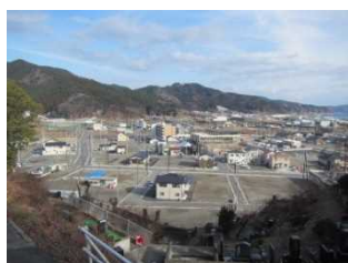
(提供: 都市再生機構 H30.1撮影)
