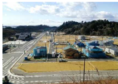
地区の状況 (H29.12撮影)
