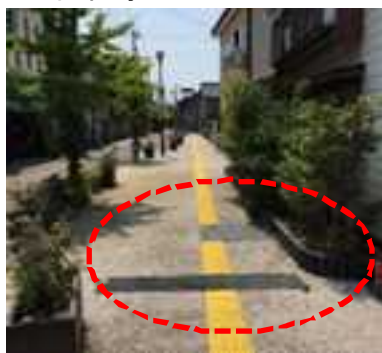
水路上部の様子
