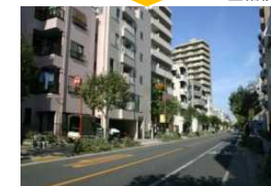
沿道建築物の不燃化 整備後
