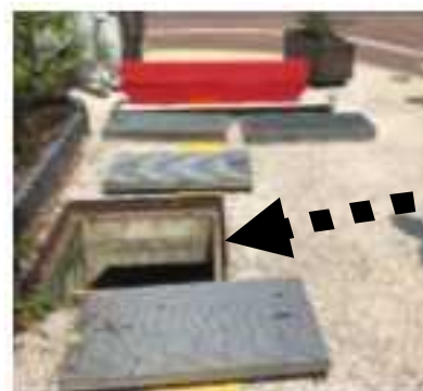
水路取水口、せき板
