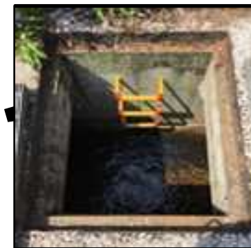
水路取水口(拡大)
