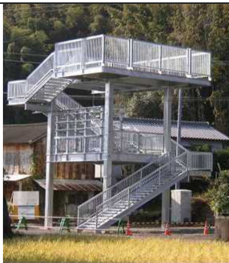
津波避難タワーの整備 (高知県四万十市)
