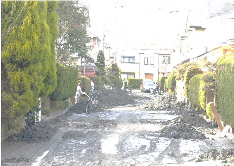
宅地内からの土砂搬出
