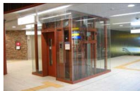
エレベーター(段差解消)
