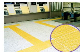
視覚障害者誘導用ブロック
