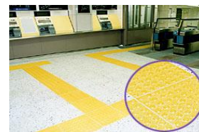
視覚障害者誘導用ブロック
