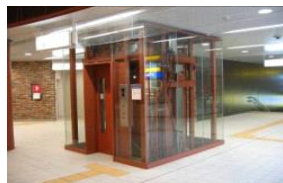
エレベーター(段差解消)
