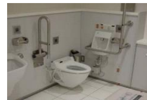
障害者対応型トイレ
