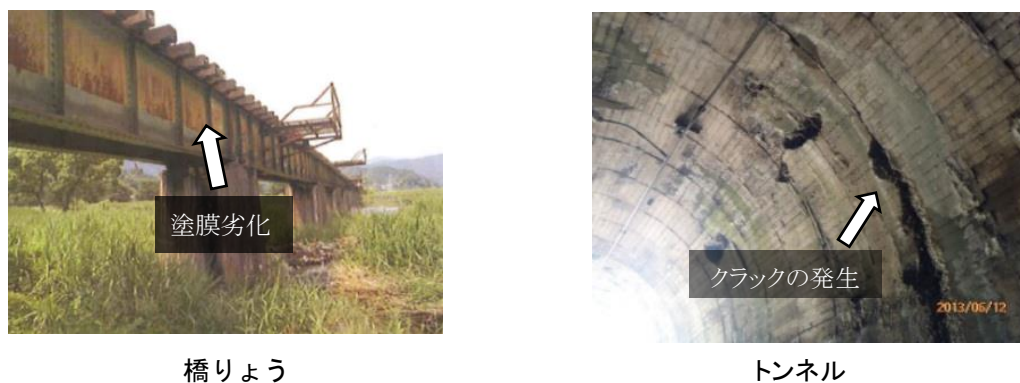
図4：老朽化が進んでいる施設の例
