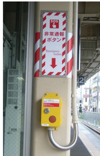
非常停止押しボタン
