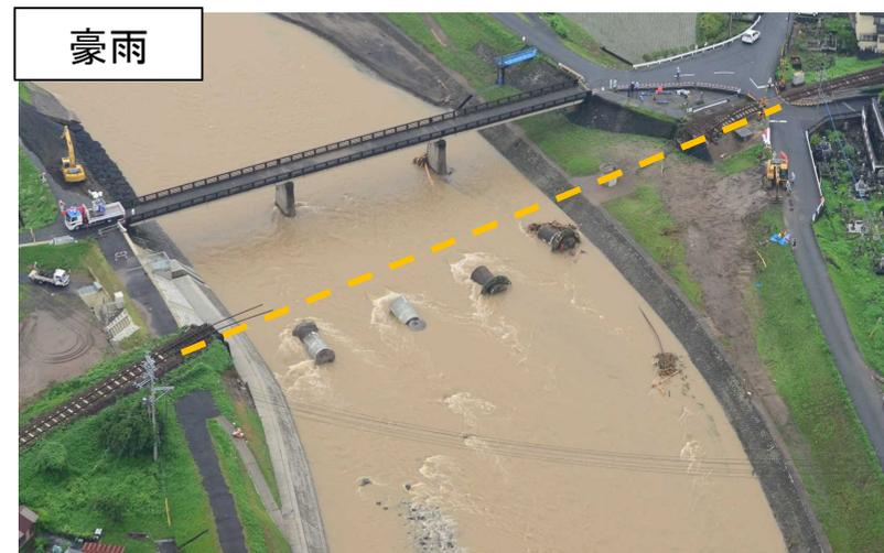
(影響)九州北部豪雨により橋りょうが流失し、現在、復旧工事を実施中。(平成30年7月14日運転再開予定)
