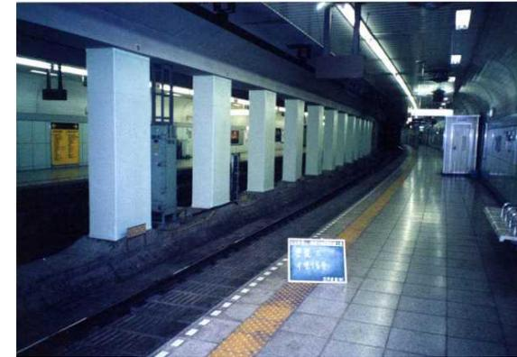
中柱を鋼板により補強
