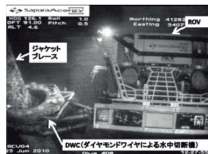
(f)ROV (Remotely Operated Vehicle) によるDWC切断装置のジャケット部座右への海中取付
