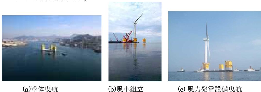
図 3.4.6 7MW 洋上風力発電設備の施工状況
