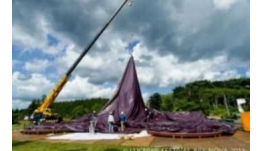
設置中の様子
