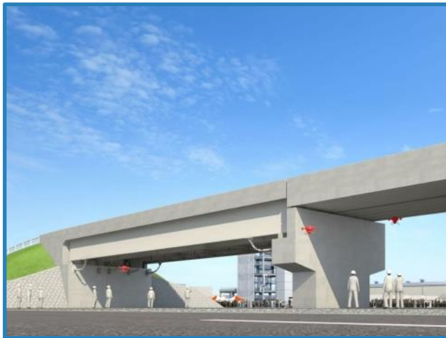
福島ロボットテストフィールドの試験用橋梁 構造形式：鋼単純鈹桁の多主桁と少数主桁、 PC単純プレテンT桁と床版橋
