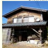
改修前 (空き家)
