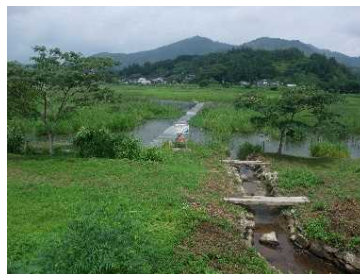
日下川調整池 全景
