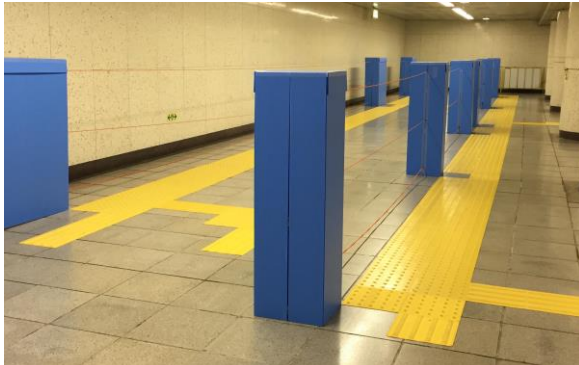
写真 - 1 敷設全体風景
