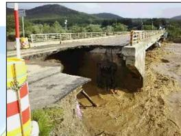
国道38号 太平橋 橋台背面洗掘（南富良野町）
