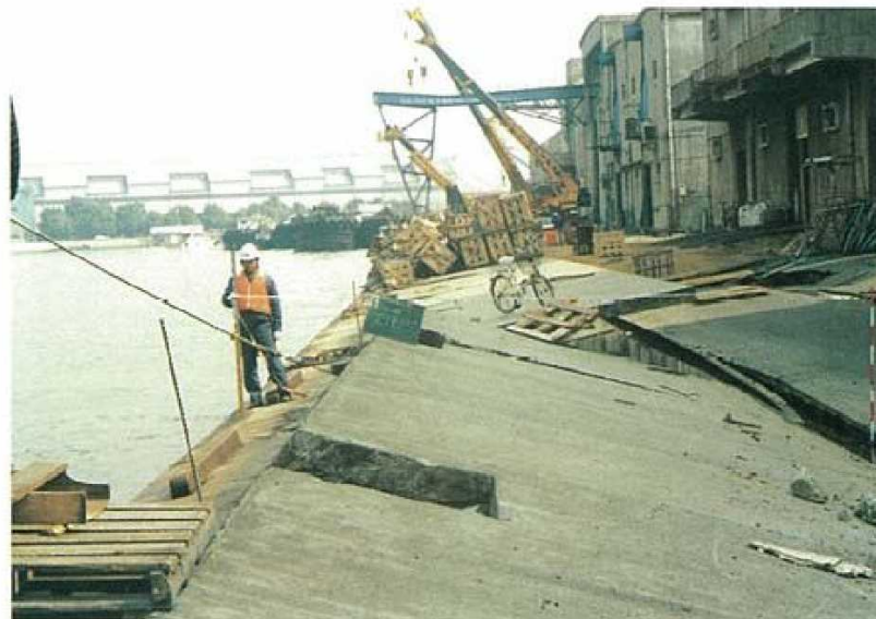
写真-4.2.4.25 新港東、㊸旧貯木場北側物揚場の被災状況
