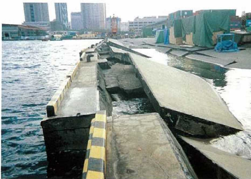
出典) 港湾技研資料 No.857 1995年兵庫県南部地震による港湾施設等被害報告
