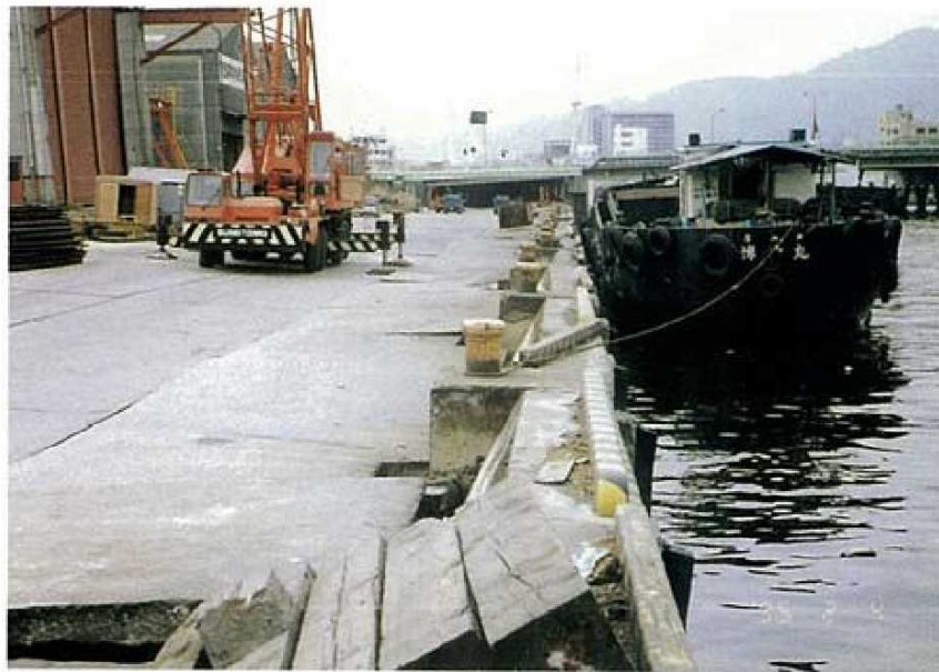
写真-4.2.1.1 東部内貿埠頭-4.0m物揚場 (施設番号①) 被災状況
