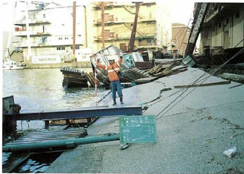
写真-4.2.3.18 摩耶埠頭-4m物揚場その4, その5
