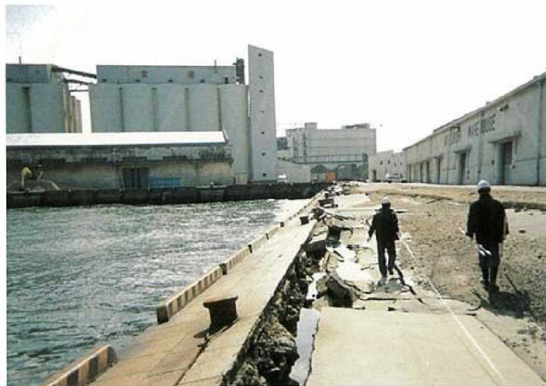
写真-4.2.4.12 新港東、④第5～6突堤間物揚場の被災状況
