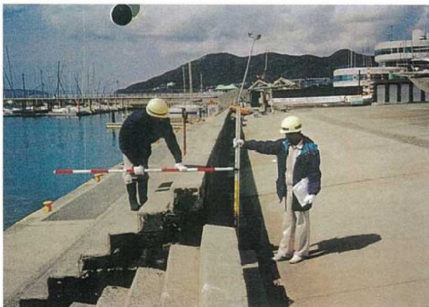
写真-4.2.8.48 須磨港護岸②(施設番号②)被災状況
