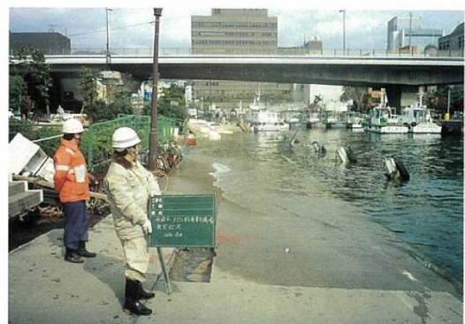
写真-4.2.6.6 神戸港中突堤メリケン波止場東物揚場 (-2.7m) 被災状況
