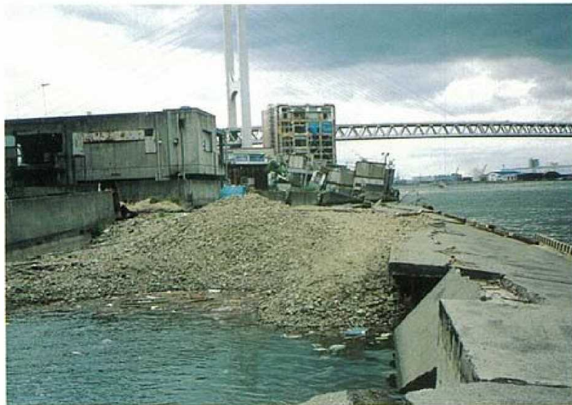
写真-4.2.1.4 東部内貿埠頭-5.0m岸壁 (施設番号④) 被災状況
