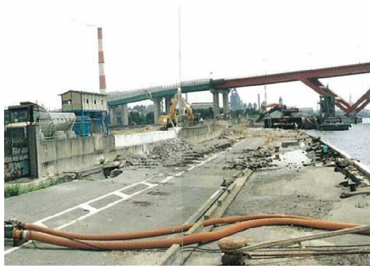
写真-4.2.1.31 灘埠頭-4.5m岸壁(施設番号㊟)被災状況
