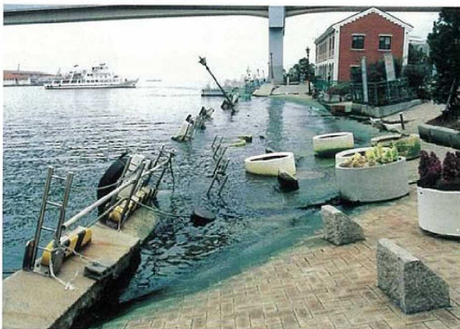
写真-4.2.6.5 神戸港中突堤メリケン波止場東物揚場 (-2.7m) 被災状況
