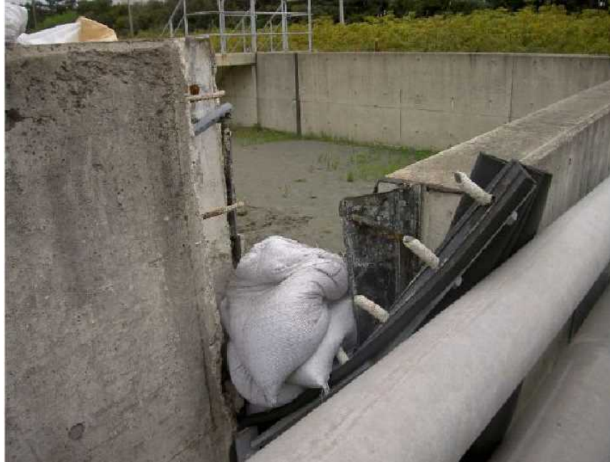
出典) 千葉県石油コンビナート防災アセスメント検討部会 耐震対策分科会検討結果報告書 H23.10
