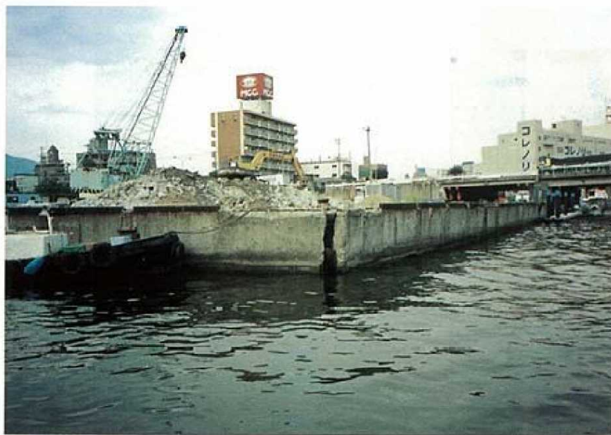
写真-4.2.1.10 本庄港東部第4港区岸壁(施設番号⑩)被災状況
