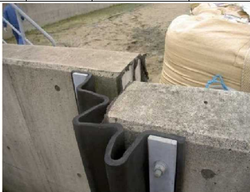
出典) 千葉県石油コンビナート防災アセスメント検討部会 耐震対策分科会検討結果報告書 H23.10
