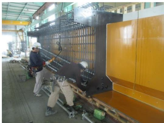
写真-解 3.4.5 コンポ桁鉄筋への適用事例
