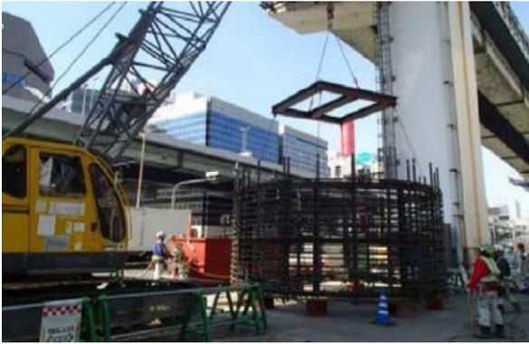
写真-解 3.4.1 ケーソン基礎への適用事例
