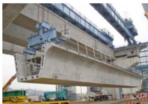
写真-解 4.2.2 U型コア断面の施工例 5)
