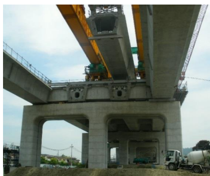
写真-解 4.2.1 箱型コア断面の施工例 5)
