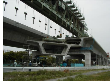
(4) プレキャストセグメントの架設
