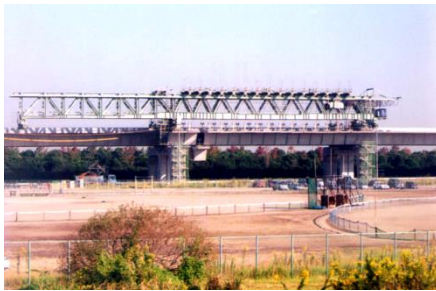
(5) プレキャストセグメントの架設
