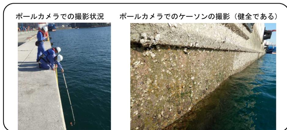
写真 解 I-2 ポールカメラによる確認状況
