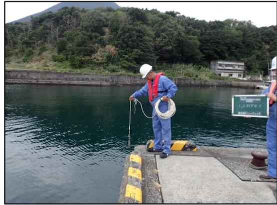
写真 解 I-1 レッド測深の器材と測深状況
