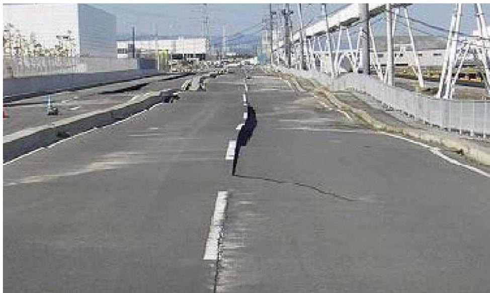
図 解 H-11 液状化による道路の損傷<sup>16)</sup>
