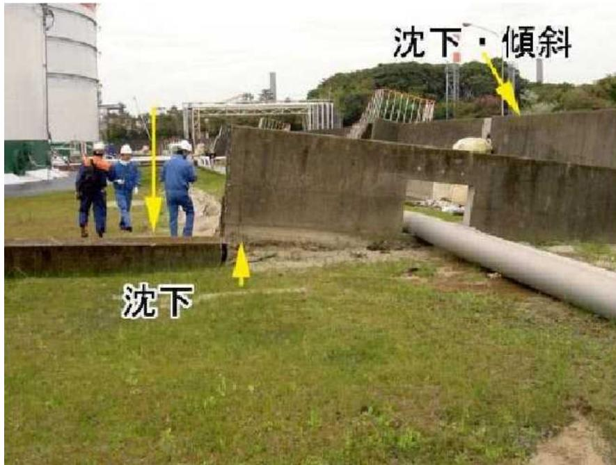
図 解 H-9 液状化により傾斜した防油堤<sup>14)</sup>
