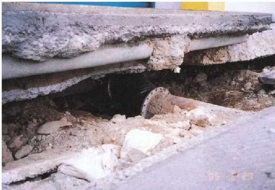
図 解 H-10 側方流動による地下埋設管の損傷<sup>15)</sup>
