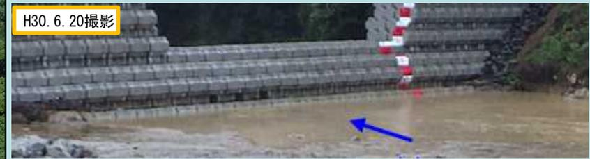
出水期前に緊急的に設置した遊砂地が、H30.6.19出水の際に約650m<sup>3</sup>の土砂を捕捉し効果を発揮!!
