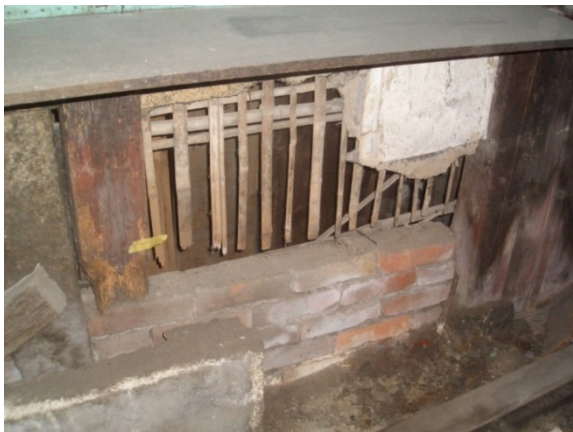
柱及び壁の腐食例
