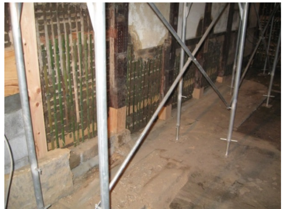
土壁の増設と柱の根継ぎ補修
