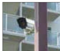
◀ 駐車場における防犯カメラの設置例
