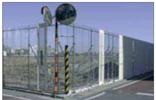
見通しが確保された仮囲いとカーブミラーの設置
