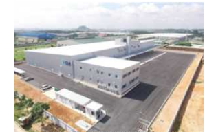
CLKコールドストレージ社の冷蔵・冷凍倉庫 (2016年完成)
