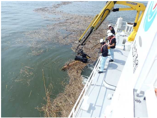
[7月14日 クレーンで流木を回収中]
