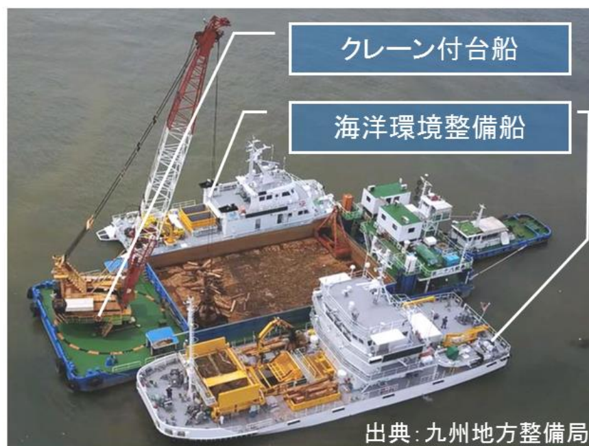
クレーン付台船を用いた漂流物の回収作業 (平成29年度における九州地方整備局の事例)
