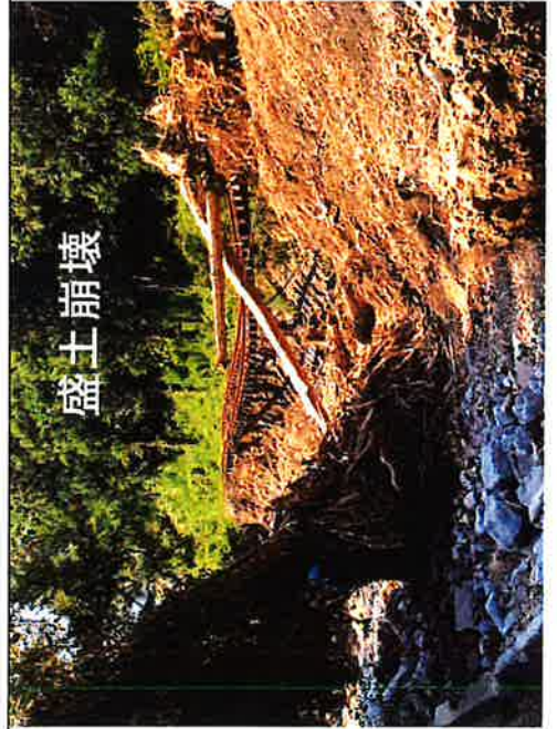
盛土崩壊・土砂流入(下宇和(しもうわ)駅・立間(たちま)駅間)
