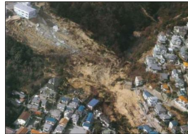
阪神・淡路大震災での大規模盛土の滑動崩落による被害(兵庫県西宮市)
