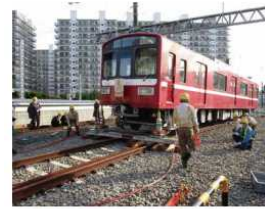
▲異常時復旧訓練
