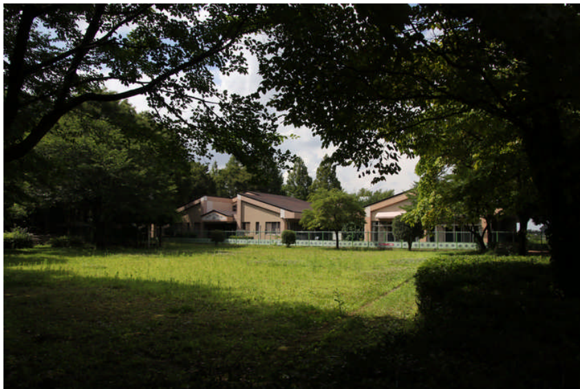
旧ふれ愛センター建物①
