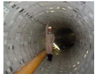
浸水対策用雨水貯留幹線
